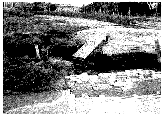
地割れと陥没のダブルパンチ
