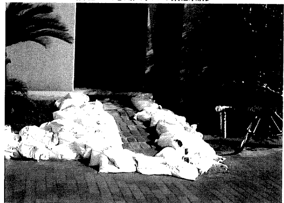
段差ができた入り口の緊急補修
